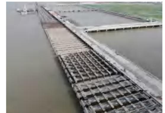
码头预制梁安装位置精准控制
