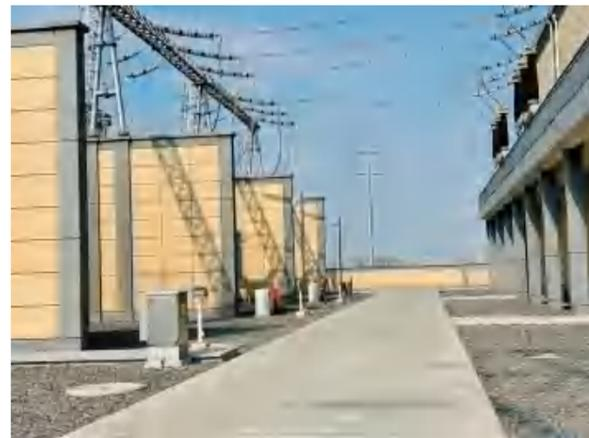
高、中压侧三相软导线、引下线弧垂一致，间隔棒间距排列整齐美观，工艺精良。
