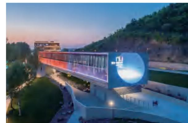
地质科普馆 D 区为新建建筑，采用钢结构大跨桁架 - 拉杆混合结构
