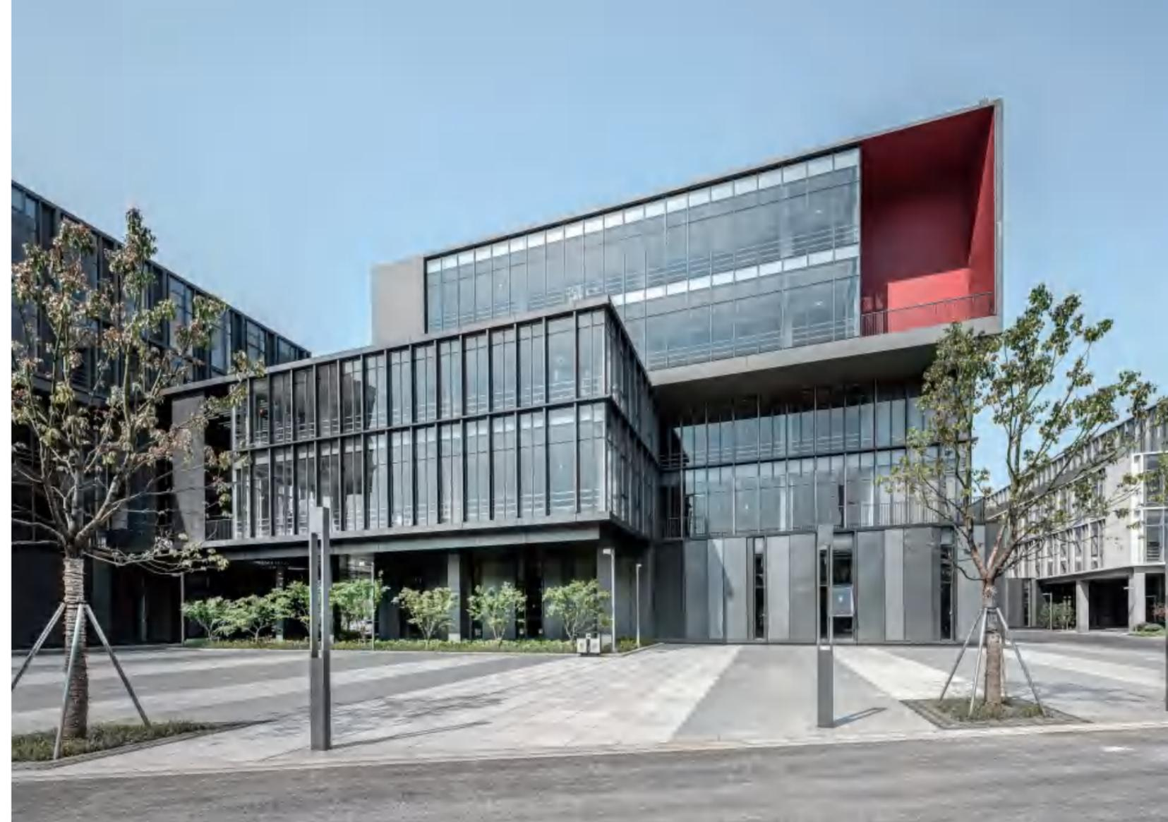
北侧施工严谨、板块接缝平整严密、缝宽一致、通透亮丽
