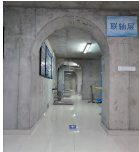
水电站联轴层、墙面为清水混凝土
